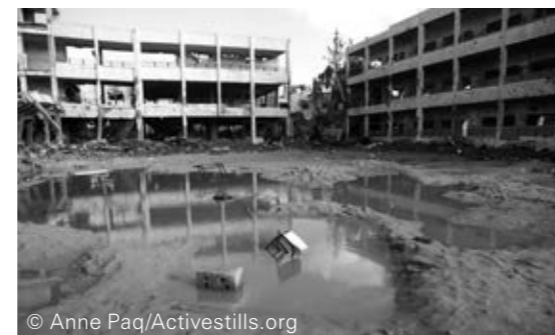
Während der Attacke im Sommer 2014 schwer beschädigte Schule im Shujaiya-Quartier, Gaza Stadt, Nov. 2014
